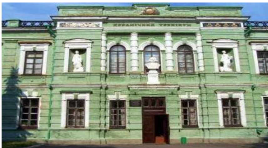
Рис. 2.27. Будівля Музею кераміки в м. Миргород [43]
