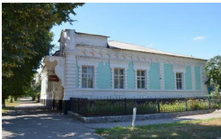
Рис. 2.6. Будівля краєзнавчого музею у м. Хорол [43]
