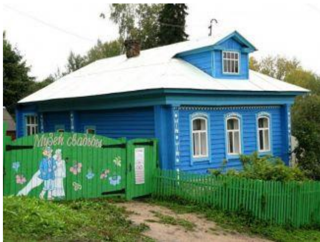
Рис. 2.22. Будівля Музею українського весілля в с. Великі Будища [43]
