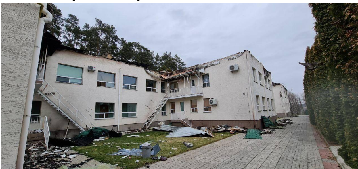
Рис. 6 Будівля Ірпінської біблійної семінарії
